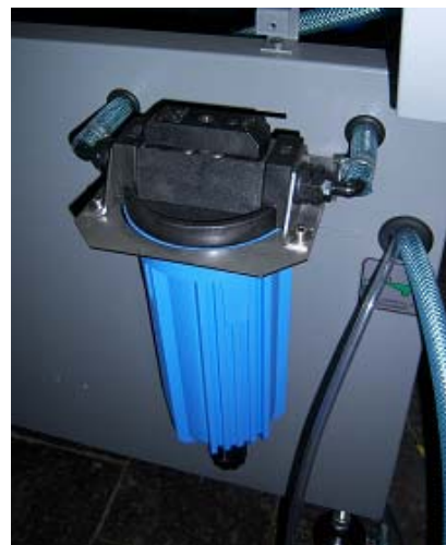
Bild 4, Entwicklerfilter mit integriertem Absperrventil
