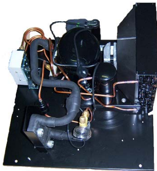
Bild 13, Montage des Kühlaggregats, alte Ausführung mit neuen Teilen
