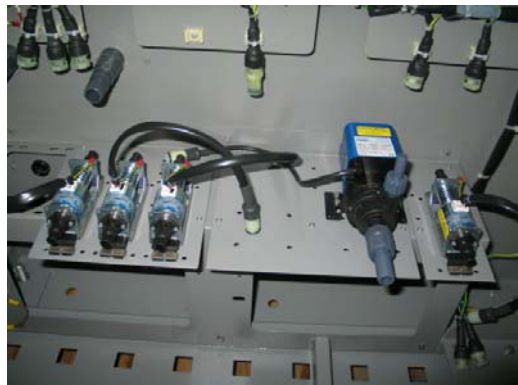
Bild 8, Montage der neuen Komponenten
