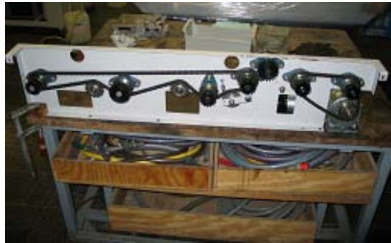
Bild 6, Demontage von Ketten und Lager der Antriebseinheit
